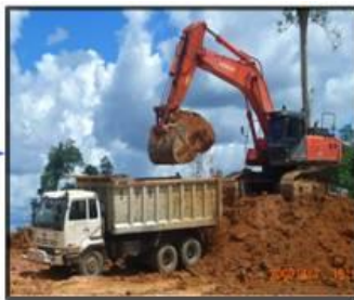
Pemindahan dan Penyimpanan Topsoil Excavator & Truck
