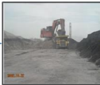
Pemindahan Tanah Penutup Excavator & Truck
